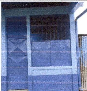
FOTO 5: SUSTITUCION DE VENTANA DE MAYA POR METAL.
