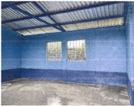
FOTO 3: SUSTITUCION DE TORTA DE CEMENTO POR PISO DE GRANITO AULAS DEL MODULO 1.
