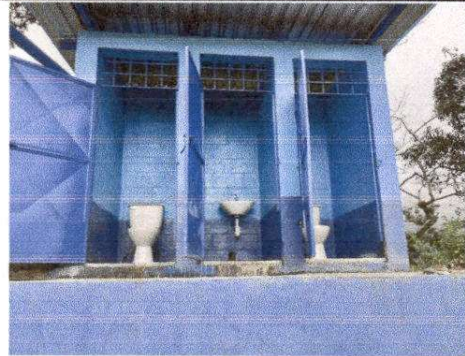
FOTO 4: SUSTITUCION DE TECHO, CAMBIO DE TAZAS, LAVAMANOS Y PINTURA.
