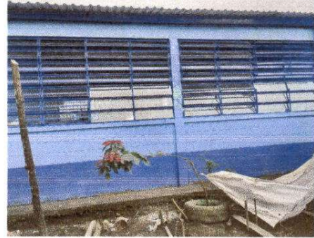
FOTO 2: SUSTITUCION DE VIDRIOS Y PINTURA DE VENTANAS.
