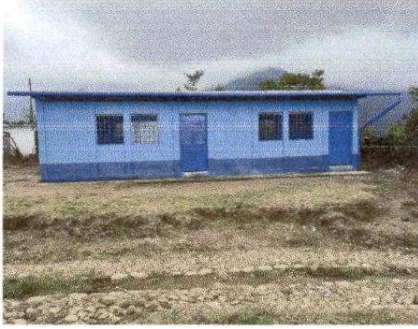
FOTO 1: CUBIERTA DE LAMINA, SUSTITUCION DE LAMINA POR LAMINA TROQUELADA ALUMINZINC CALIBRE 26
